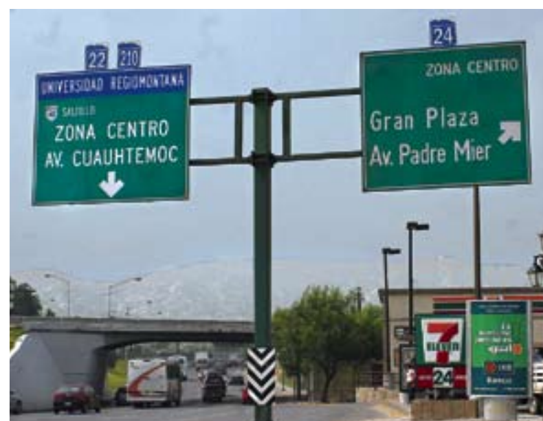
Fase preliminar de señalamiento complementario con la instalación de ejes numéricos en los tableros existentes.
